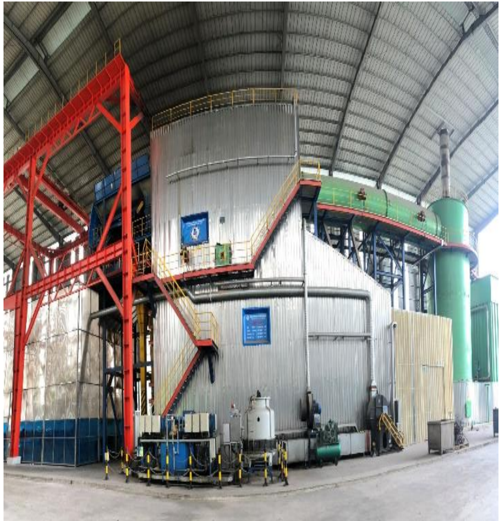
Lò đốt rác 200 tấn/giờ do công ty thiết kế thi công với mục tiêu kép vừa đốt rác công nghiệp, sinh hoạt vừa phát điện
